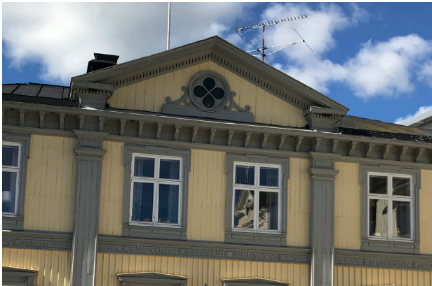
I mitten av frontespisen finns ett runt fönster indelat i fyrpass ©Falken PM
