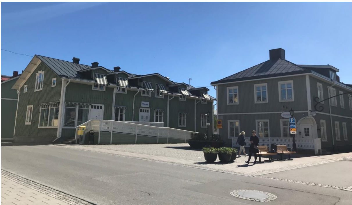
Figur 16. Nuvarande byggnad på Stjärnan 13 till vänster i bild. Stjärnan 4 till höger i bild (Ramböll 2018).
