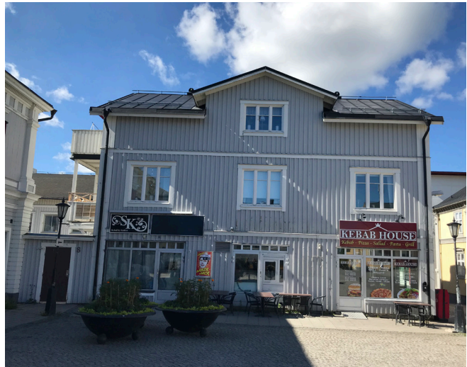
Befintlig byggnad på Ulven 5.
