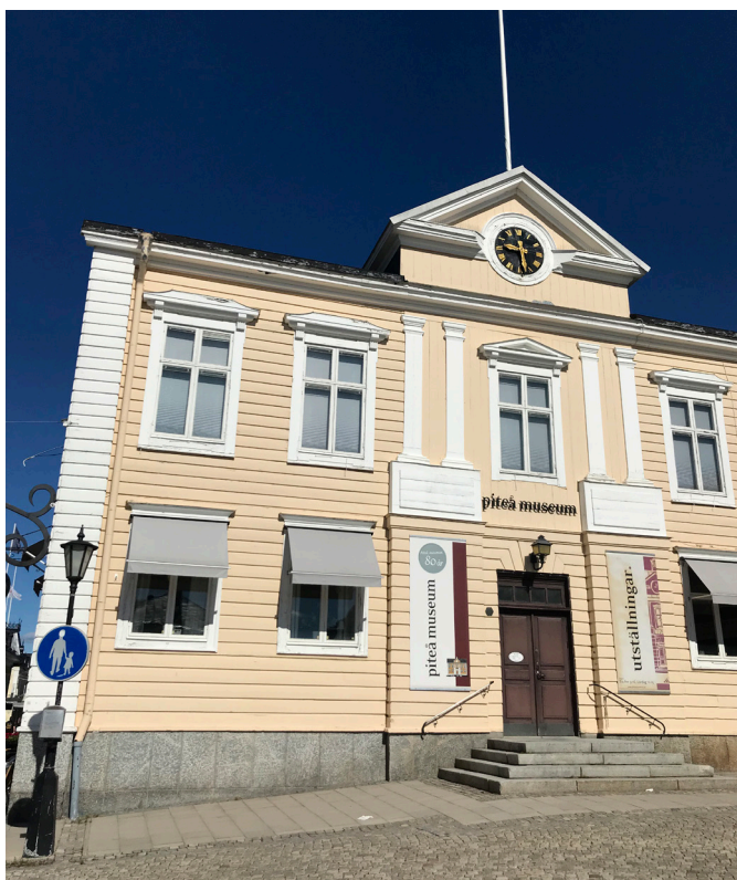
Nuvarande byggnad på Stadsvapnet 6, Rådhuset.
