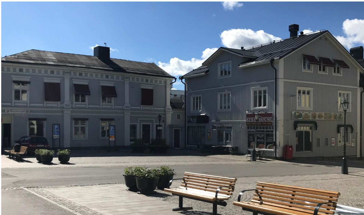
Figur 22. Nuvarande byggnad på Ulven 6 till vänster i bild (Ramböll 2018).
