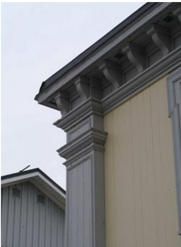
Takfotkonsol och knutlåta är utformad som en pilaster med krönande kapital. ©Falken PM
