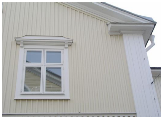
Stående locklistpanel och detaljer på fasaden och fönster. © FalkenPM
